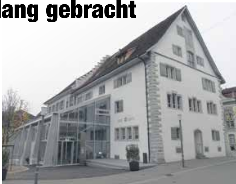
Die rückseitige Ansicht des Traubens mit statisch stabilisierendem Anbau.
