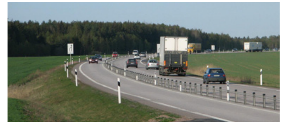
Dreispurige Hauptstrasse E20 bei Skara in Schweden
