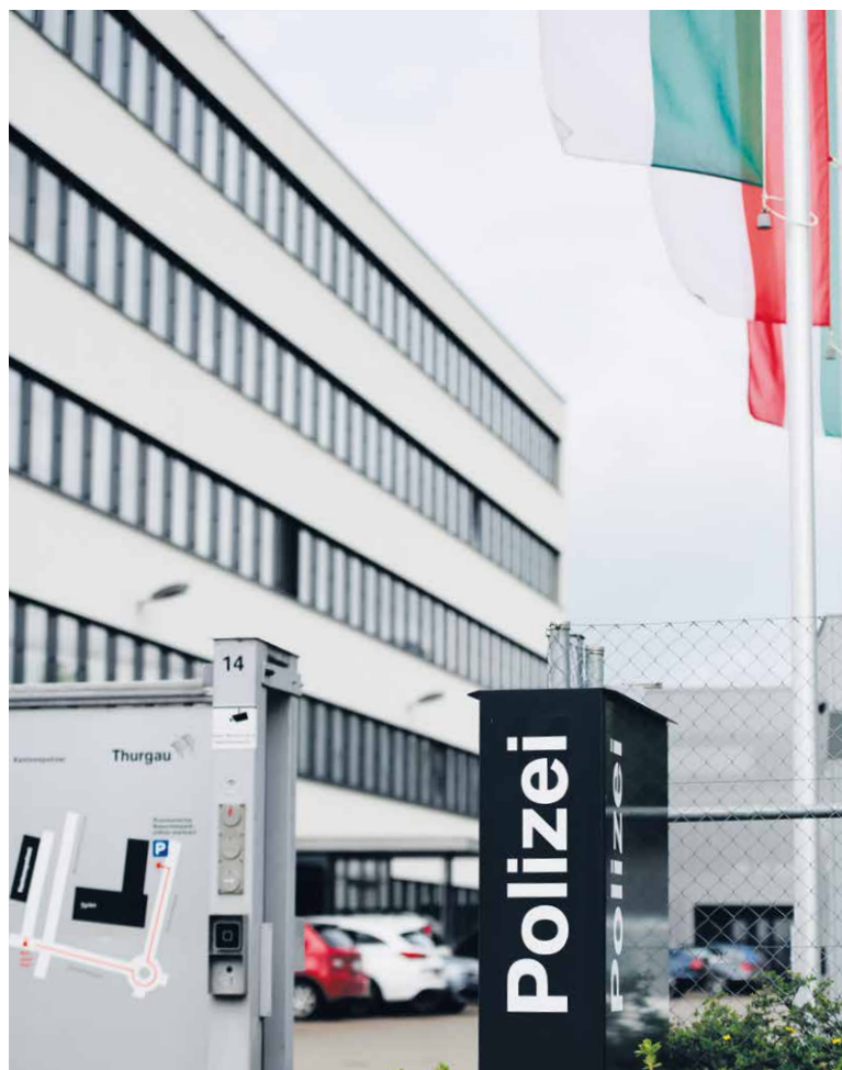
Der Eingang zum neuen Polizeiposten an der Dunantstrasse 14.
