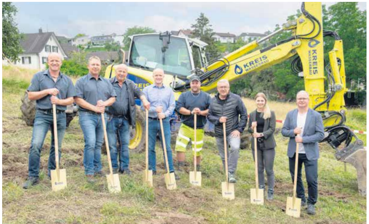
Die Bauherrschaft mit den Brüdern Marc, Sandro und Pascal Wellauer und ihrem Vater Albert Wellauer beim Spatenstich mit Maschinist Ramon Schlager, Architekt Urs Oberhänsli und den Immobilienprofis Gabriela Rihs und Daniel Brüllmann. Bild: Mario Testa
