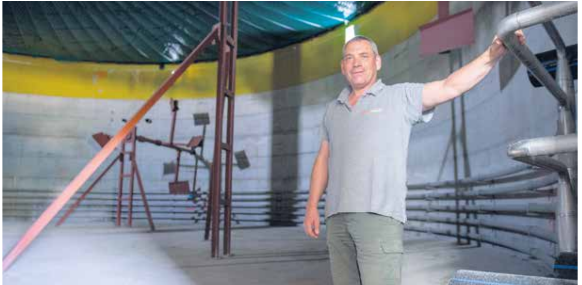
Markus Zürcher im Fermenter, dem riesigen «Bauch» der neuen Biogasanlage.
