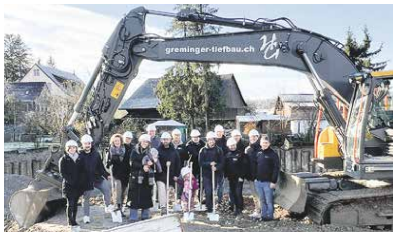
Spatenstich und Eröffnung der Baustelle an der Thurfeldstrasse 34.
