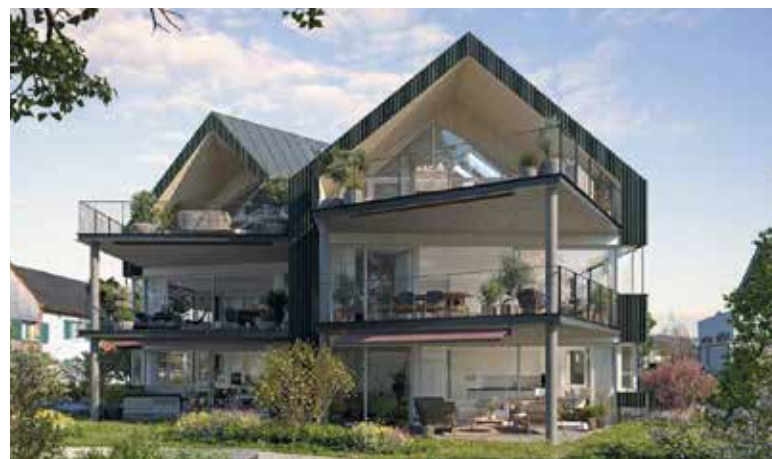
So präsentiert sich das Mehrfamilienhaus Venthura nach der Fertigstellung.
