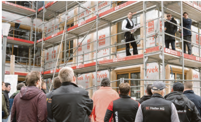
Christoph Walter und Thomas Wieland sprechen vom Gerüst zu den Handwerkern.
