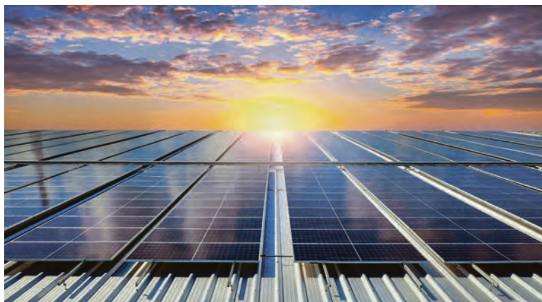
Mit Photovoltaikanlagen lässt sich eigener Strom produzieren.
