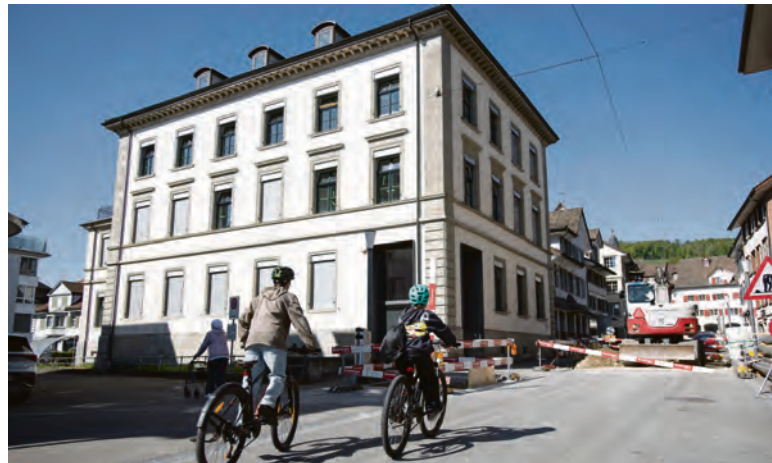
Die Schulverwaltung zieht ins erste und zweite Obergeschoss dieses Gebäudes.
