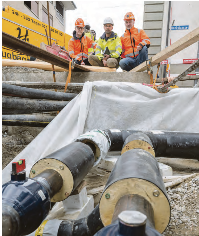
Bauamtchef Martin Belz, Matthias Altwegg von der TBW und Reto Colombo, Bereichsleiter Tiefbau blicken in die Baugrube mit den vielen Rohren.
