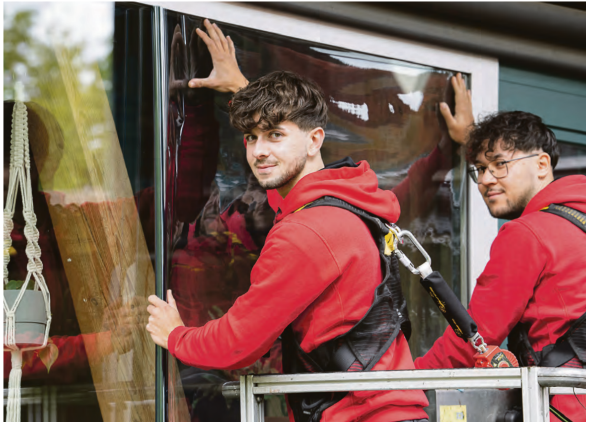
Die Fachspezialisten Marco Schwarzenbach und Pascal Sidler applizieren eine Hitzeschutz-Folie an einer Fensterscheibe.
