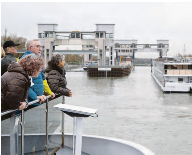
Die Passage der ersten Schleuse wird mit Spannung erwartet.
