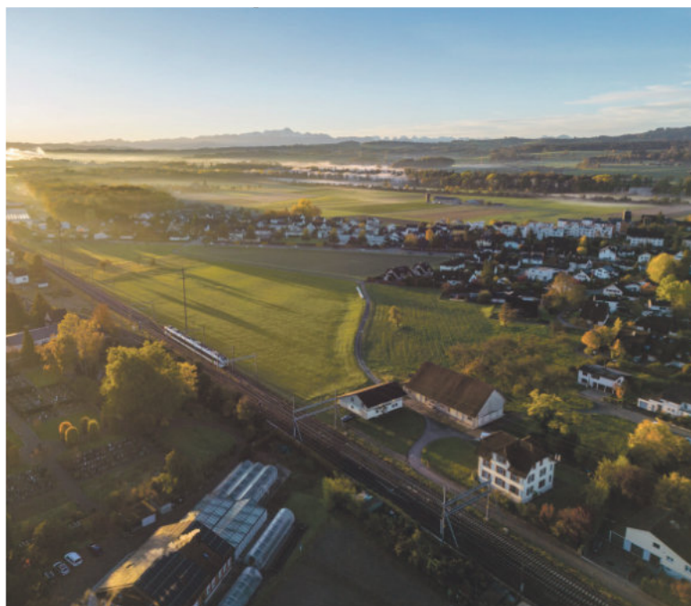
Auf dem Feldhof-Areal (grüne Wiese) soll ein neues Stadtviertel entstehen.
