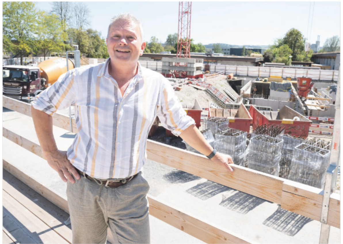
Dave Siddiqui bei den Baustellen, wo die Küche, die Tagesstruktur für Erwachsene und Verwaltungsräume entstehen.
