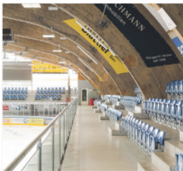
Blick in die Eishalle.
